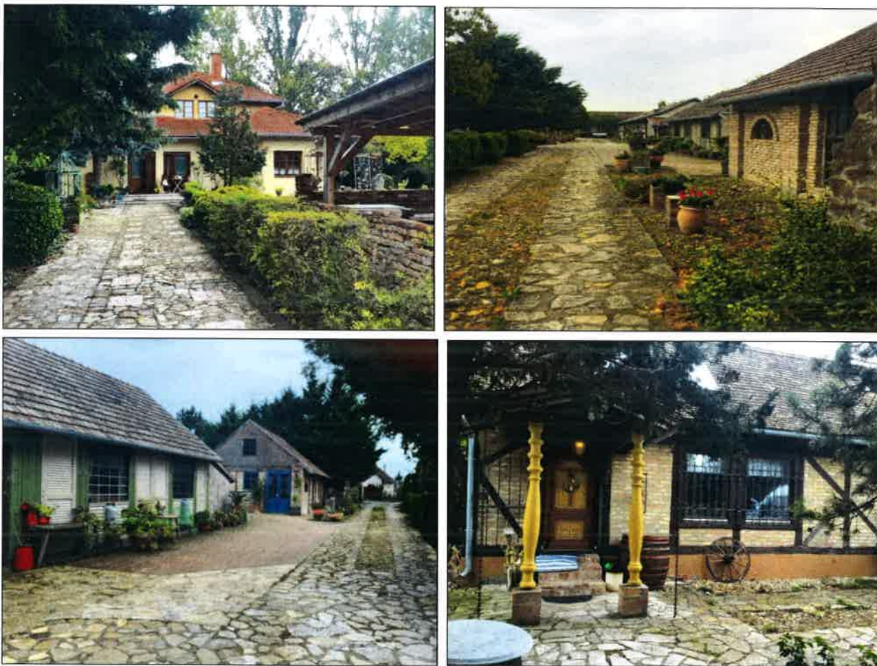
A 446 hrsz-ú telken található épületek és környezetük
